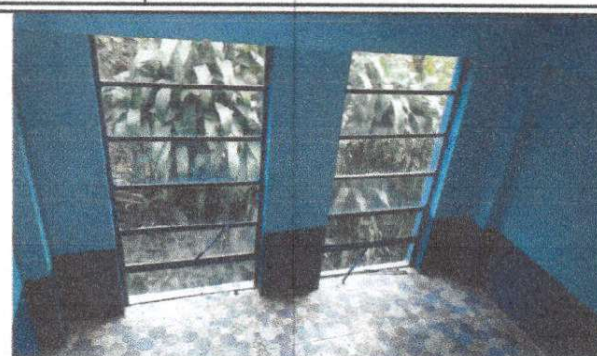
Foto 2: Mantenimiento a ventanas y sustitución de vidrios en Modulo 1.
