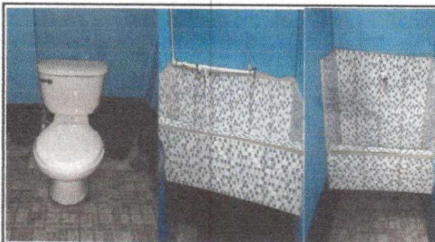
Foto 4: Servicios sanitarios y sus accesorios (sustitución de inodoros, sustitución de lavamanos y sustitución de mingitorio), en Modulo 1.
