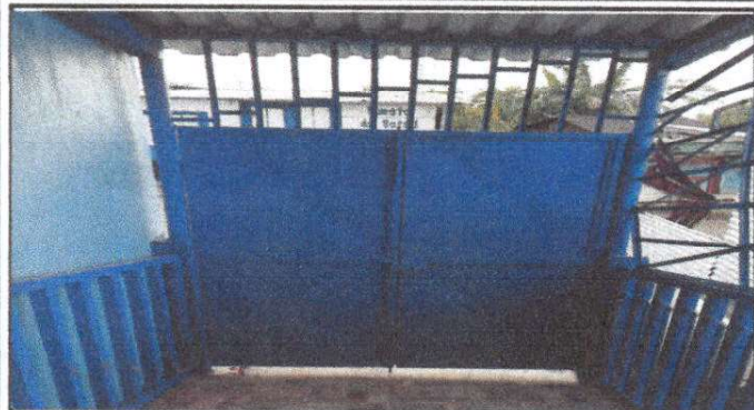
Foto 7. Mantenimiento a portones de metal.
