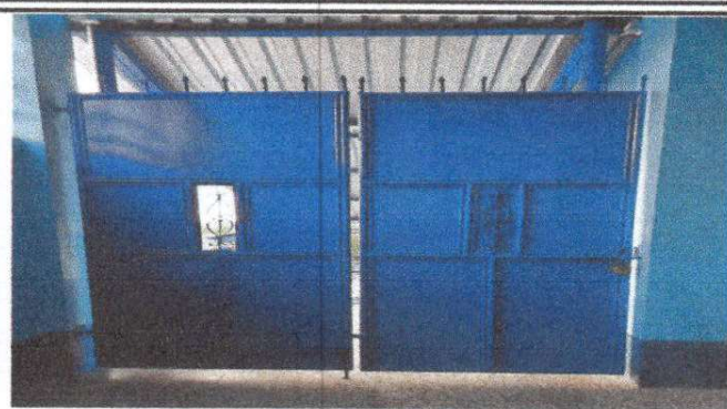
Foto 8. Mantenimiento a portones de metal.
